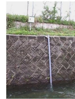
河川の設置例 (測水管 オプション)
